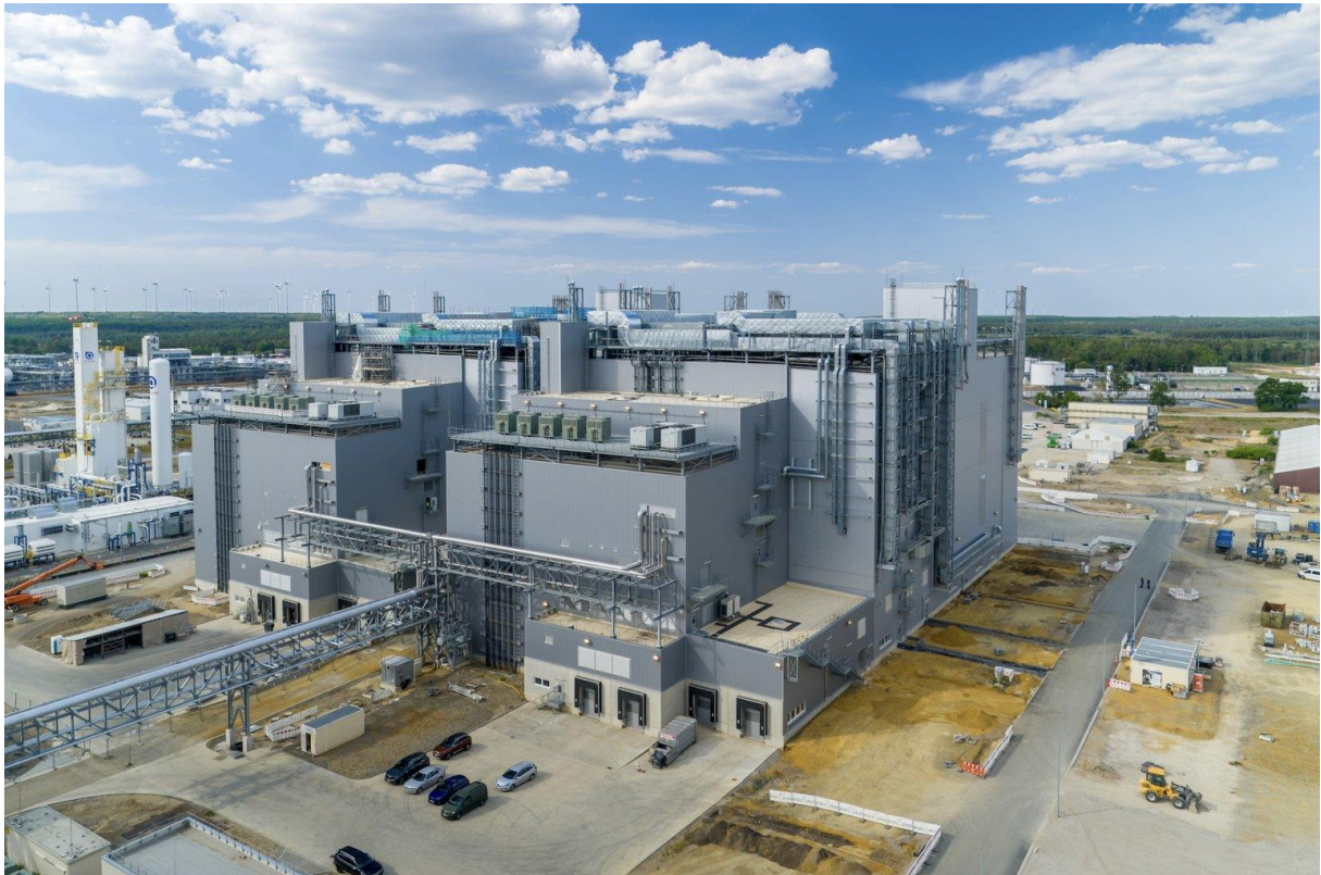
Usine BASF de recyclage de batterie inaugurée récemment en Allemagne.
