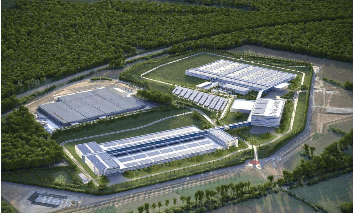
La future usine Holosolis
