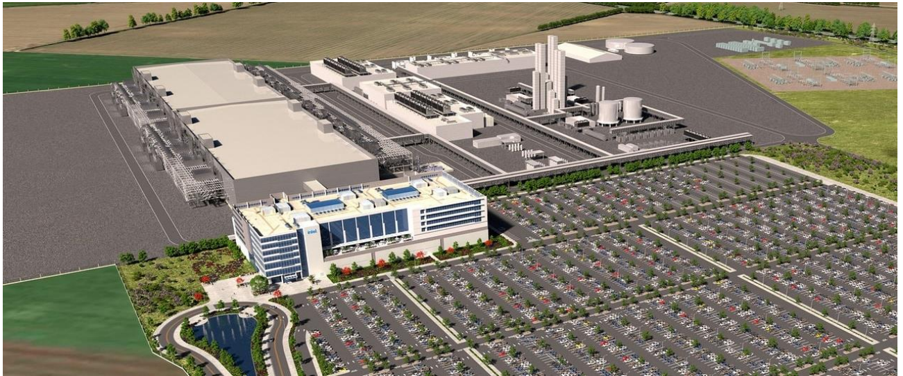
Le futur site Intel de Magdebourg en Allemagne
