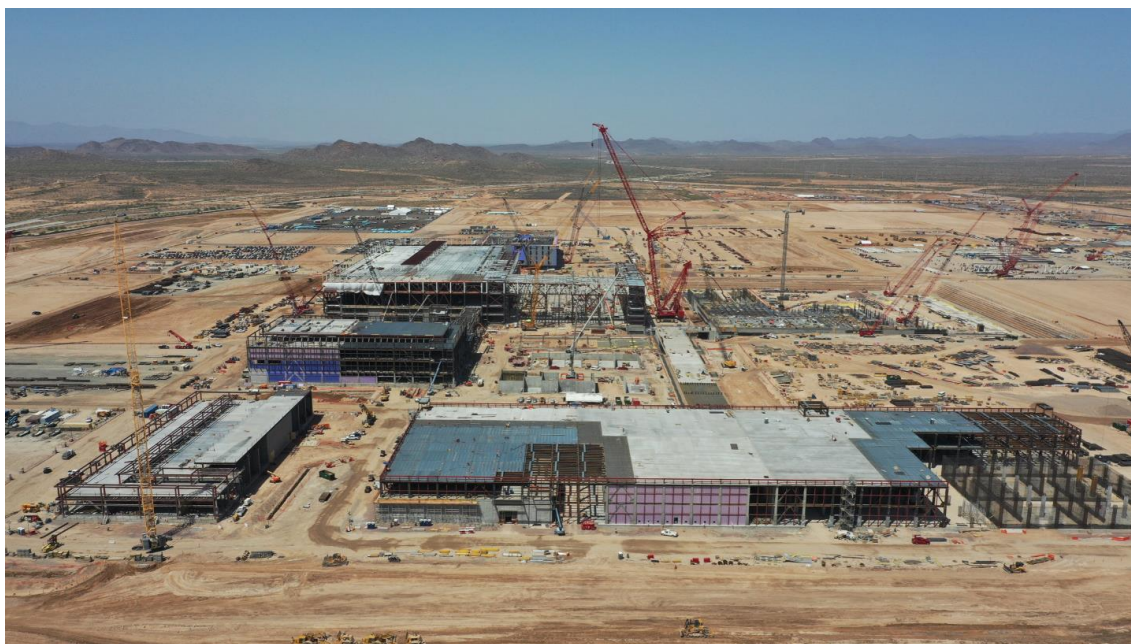
L'usine TSMC en construction à Phoenix, Arizona
