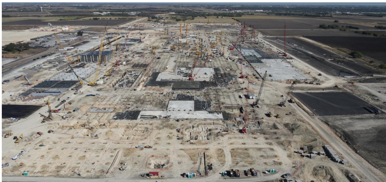
Le chantier de l'usine Samsung à Taylor au Texas
